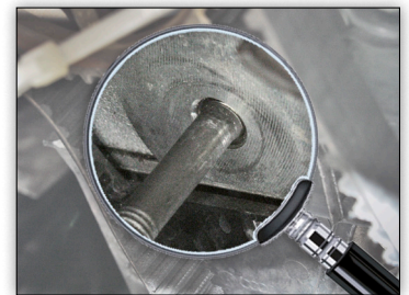
Figur 2: Skruen er skrudd inn riktig.
